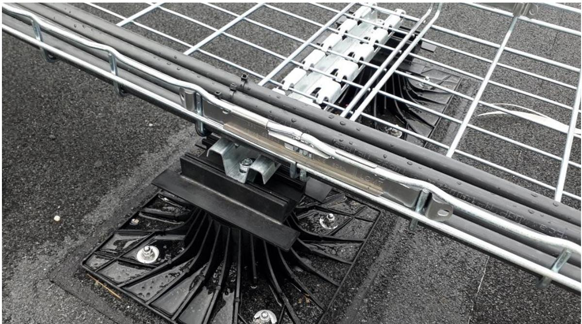
**Figure 16 : Supports de chemin de câble par oméga ou plots SOPRASOLAR FIX EVO**
